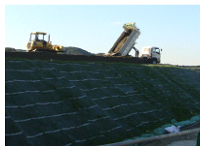
廃棄物を搬入した後、上から増設地から掘り出した土をかける。
